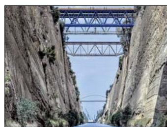
Arbeiten im Kanal von Korinth (Foto: ek/Archiv)
